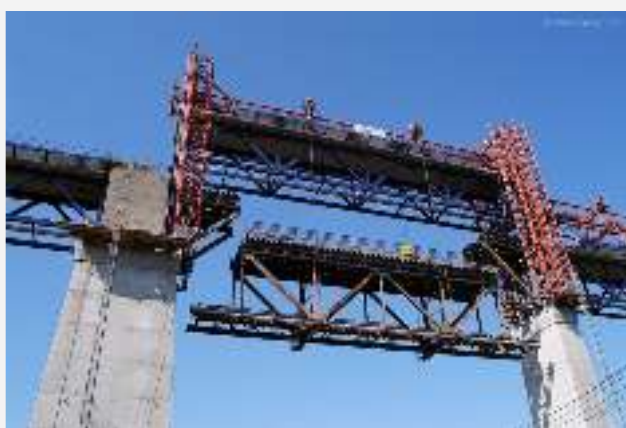
Viaduc de Moresnet : remplacement d'une travée
