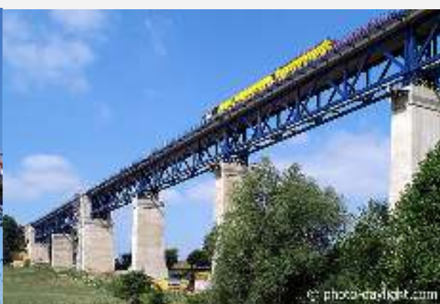
Le viaduc remis en service après rénovation
