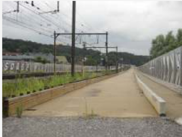
L'infrastructure terminée à Ottignies n'attend que la pose des voies et des caténaires pour faciliter l'accès à LLN.
